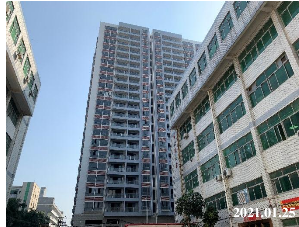
项目东面闲置住宅区
