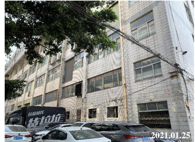
项目南面工业厂房
