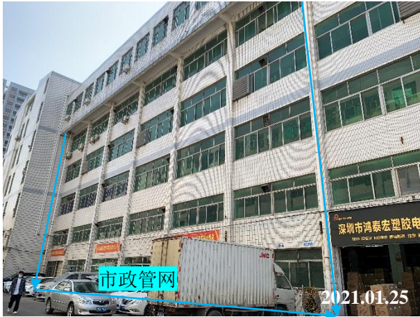
项目厂房外观
