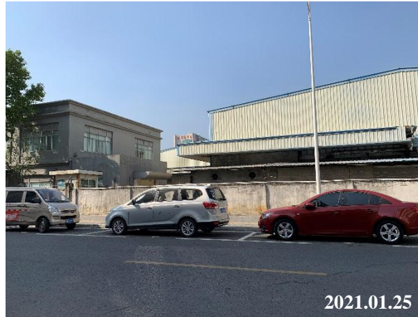
项目西面工业厂房
