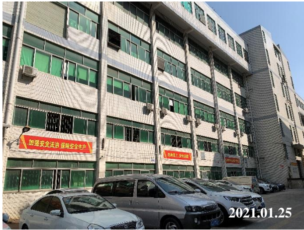
项目北面工业厂房
