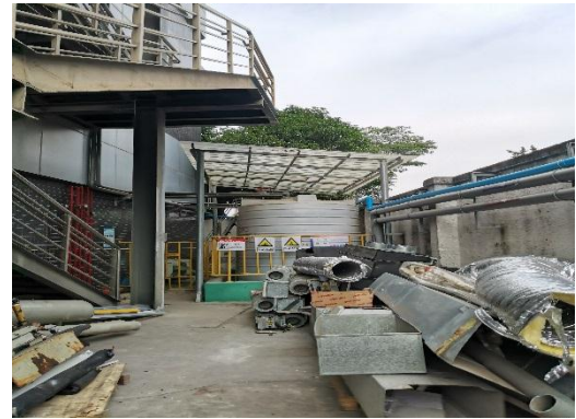
项目废水收集装置 2
