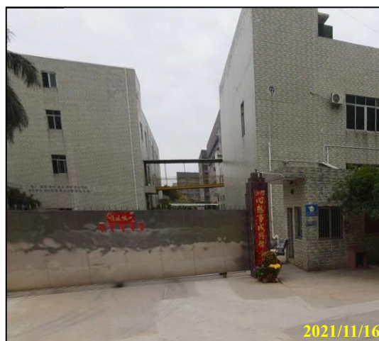
项目北面工业厂房
