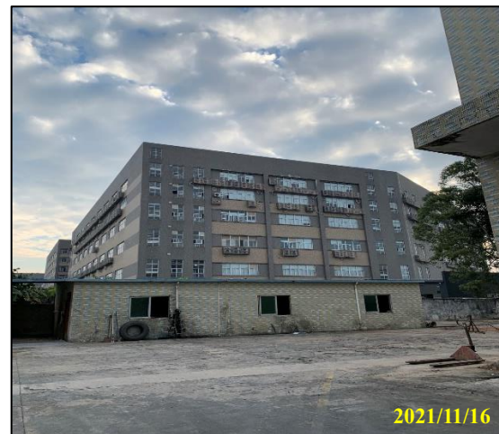
项目南面工业厂房
